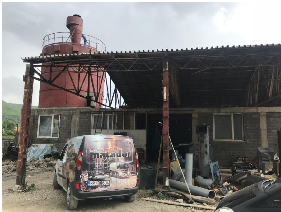
Slika 6. Izgled predmetnog objekta i lokacije sa njenim okruženjem, jun 2021.godine
